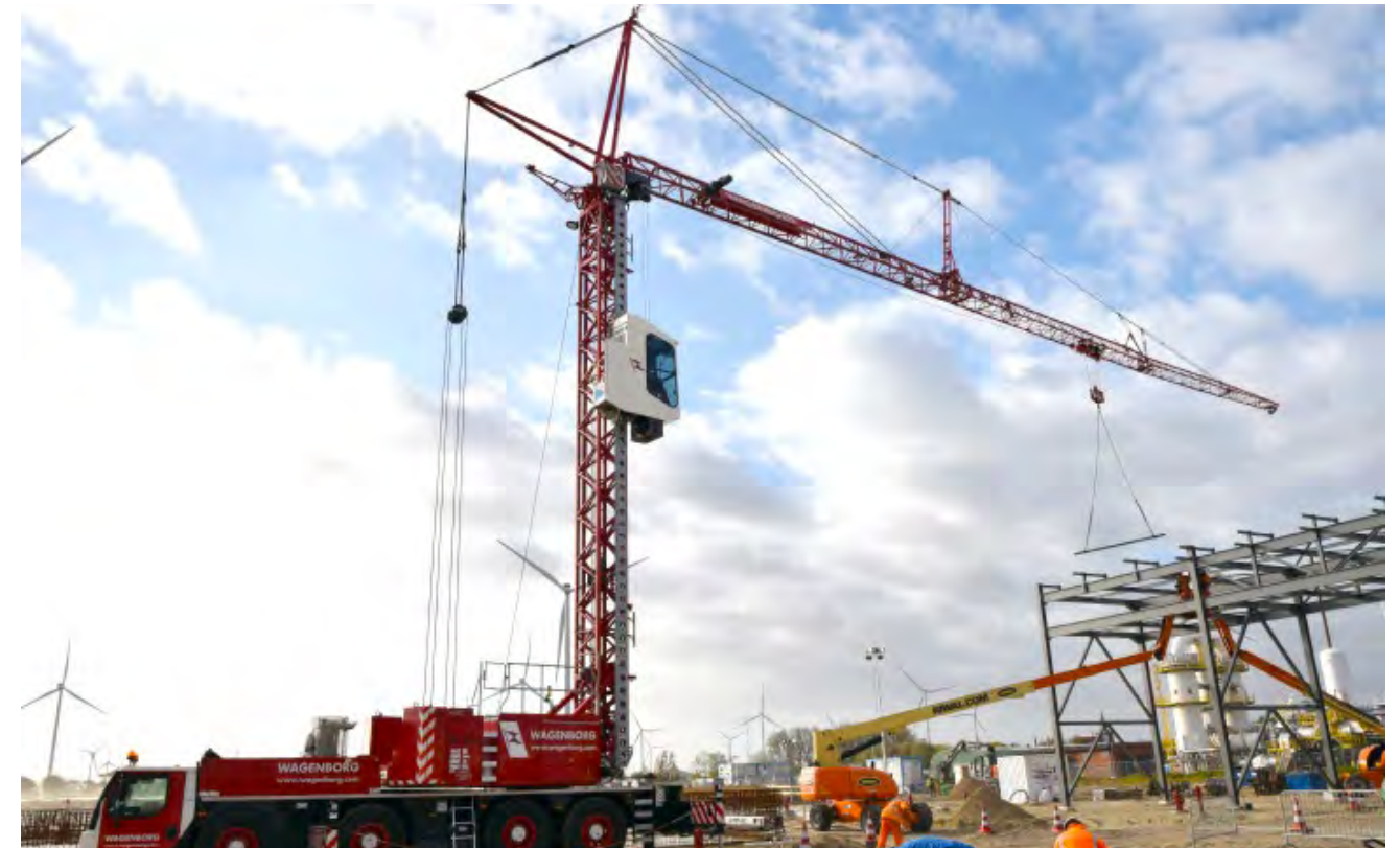
Mobiler turmdrehkran Liebherr
